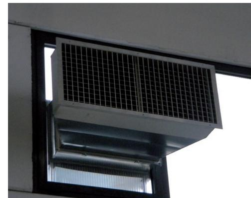
**Diffusore:** per l'immissione dell'aria calda, completo di bocchette a doppio filare regolabile e serranda di taratura.
