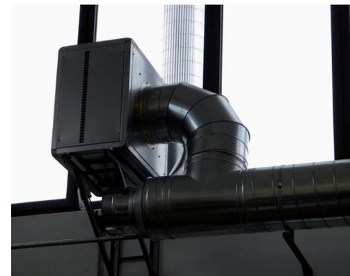
**Aspiratore:** per gas di scarico di tipo casonato e silenziato. Completo di camino per l'espulsione all'esterno.
